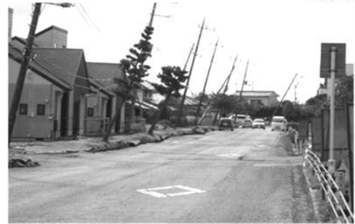
図-6 千葉県潮来市内の液状化状況 (東京電機大学地盤工学研究室)
